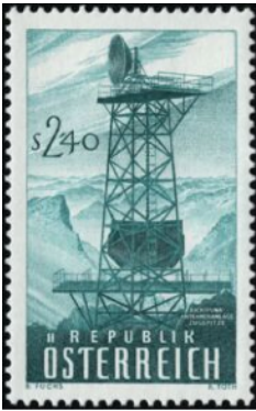
Sendemastanlage (Österreichischer Rundfunksender) und Richtfunkstation (Deutscher Funkturm)
