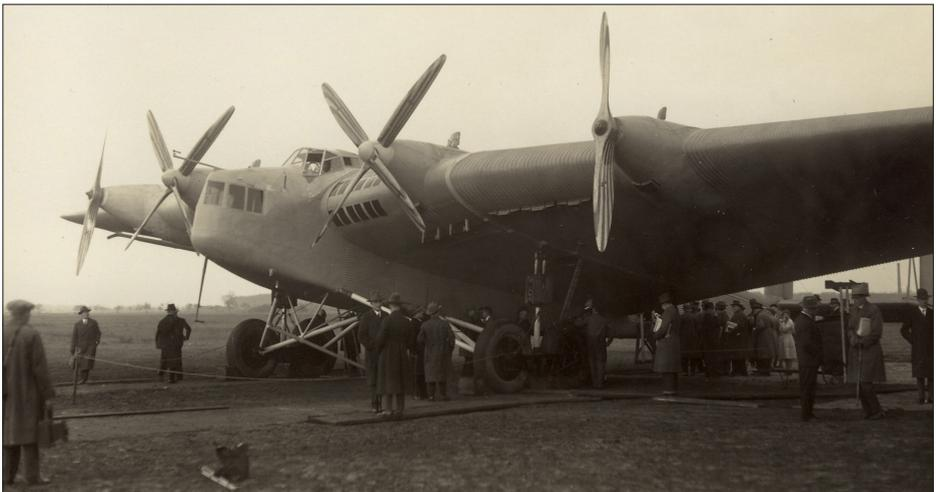
*Die G 38 mit der Werknummer 3301 (D-2000) im November 1929 anlässlich der Presseorientierung. Die Propeller hatten einen Durchmesser von etwa 4,5 m. Die äusseren Motoren waren schwächer. Deshalb genügte ein Zweiblattpropeller.*
